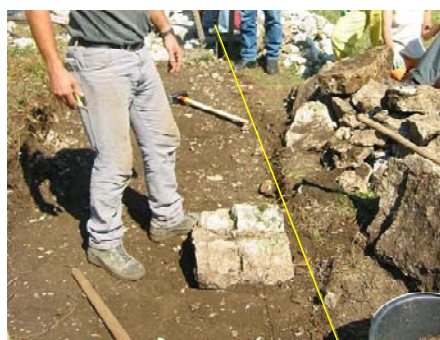
Abbildung 7: Fundamentsteine ein- bauen
