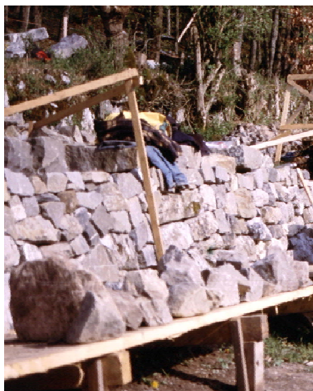
Abbildung 17: Bau ca. 30 bis 40 cm unter die Endhöhe
